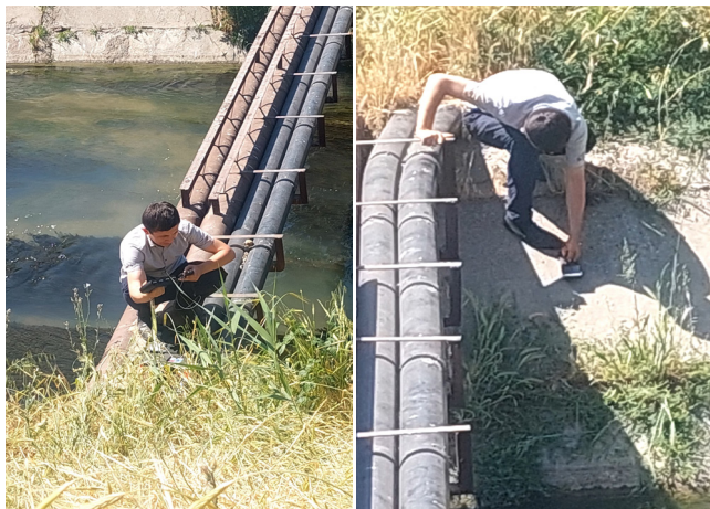
5-rasm. Salar kanalidagi yig'ma temir-beton qoplama texnik holatini nazorat qilish jarayoni.
