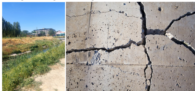
4-rasm. Salar kanalining yig'ma temir-beton qoplamalaridagi texnik nuqsonlar:
