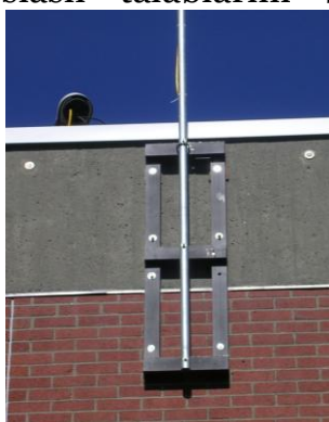
A) Flush Mount – tom qoplamasi kichik bo'lsa ishlatiladi. Eng barqaror variant
