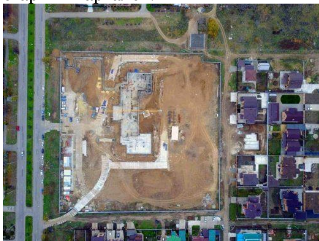
Рис.2 Использование дрона в процессе мониторинга строительства
