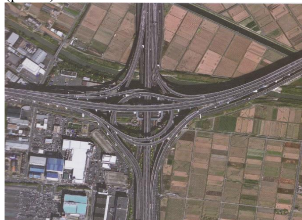
Рис.4. Транспортная развязка на высокодетальном космическом снимке
